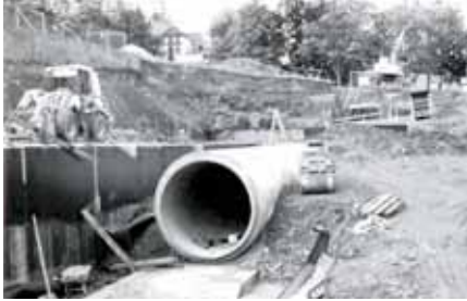
Die Arbeiten am Regenrückhaltebecken haben begonnen
